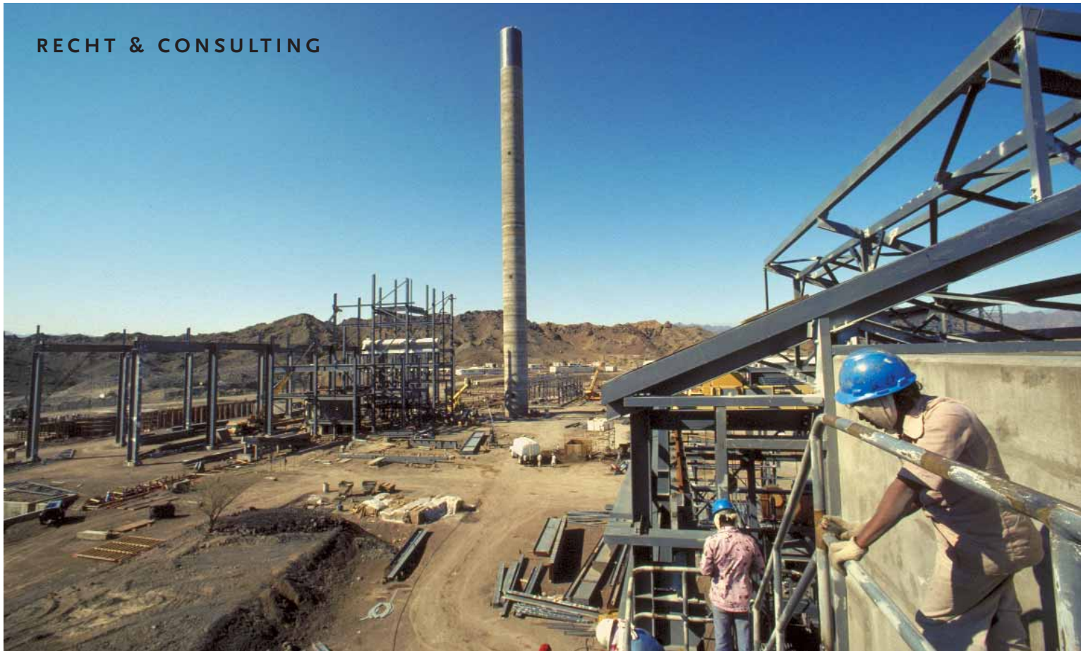
Bau einer Kupferschmelzanlage der Oman Mining L.C.C. in der Nähe von Soha.
